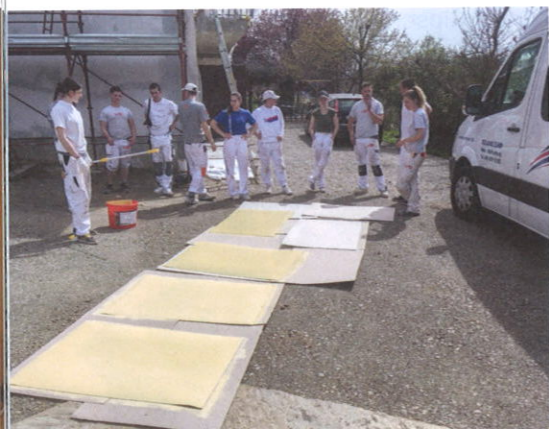
Die Lernenden bei der Bemusterung der Farbtöne für die Fassade.
